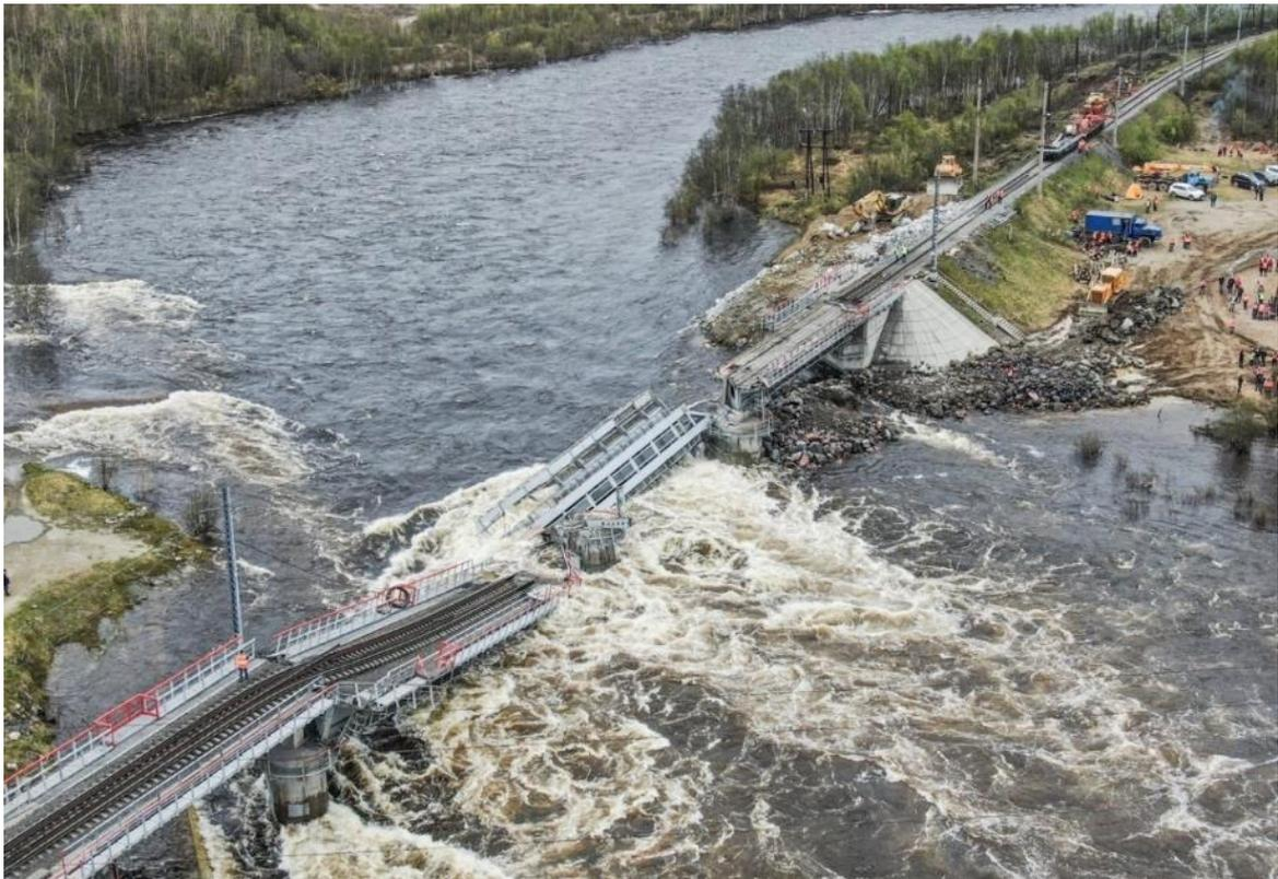
Рисунок 1.3 – Последствия некорректного учета факторов, влияющих на глубину размыва
