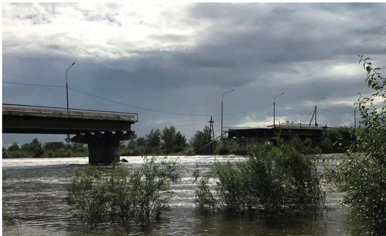
Рисунок 1.8 – Нарастание крена опоры и обрушение вследствие размыва [122]
