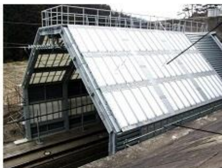
Рисунок 1.15 – Композитная порталная конструкция с остеклением
