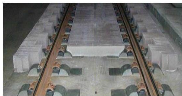
Рисунок 1.28 – Конструкция ВСП с акустическими поглотителями
