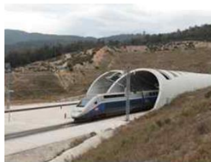
Рисунок 1.16 – Выносная порталная конструкция с перфорацией
