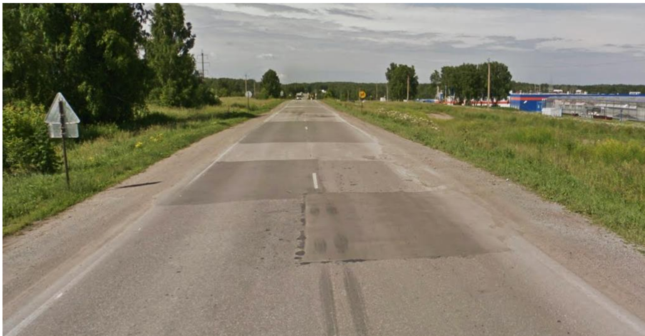
Рисунок 1.5 – Участки фрагментарного переустройства дорожной одежды
